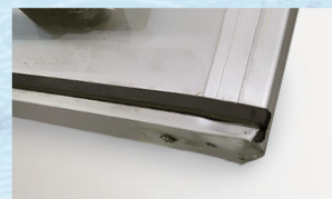
● パネルが変形している
